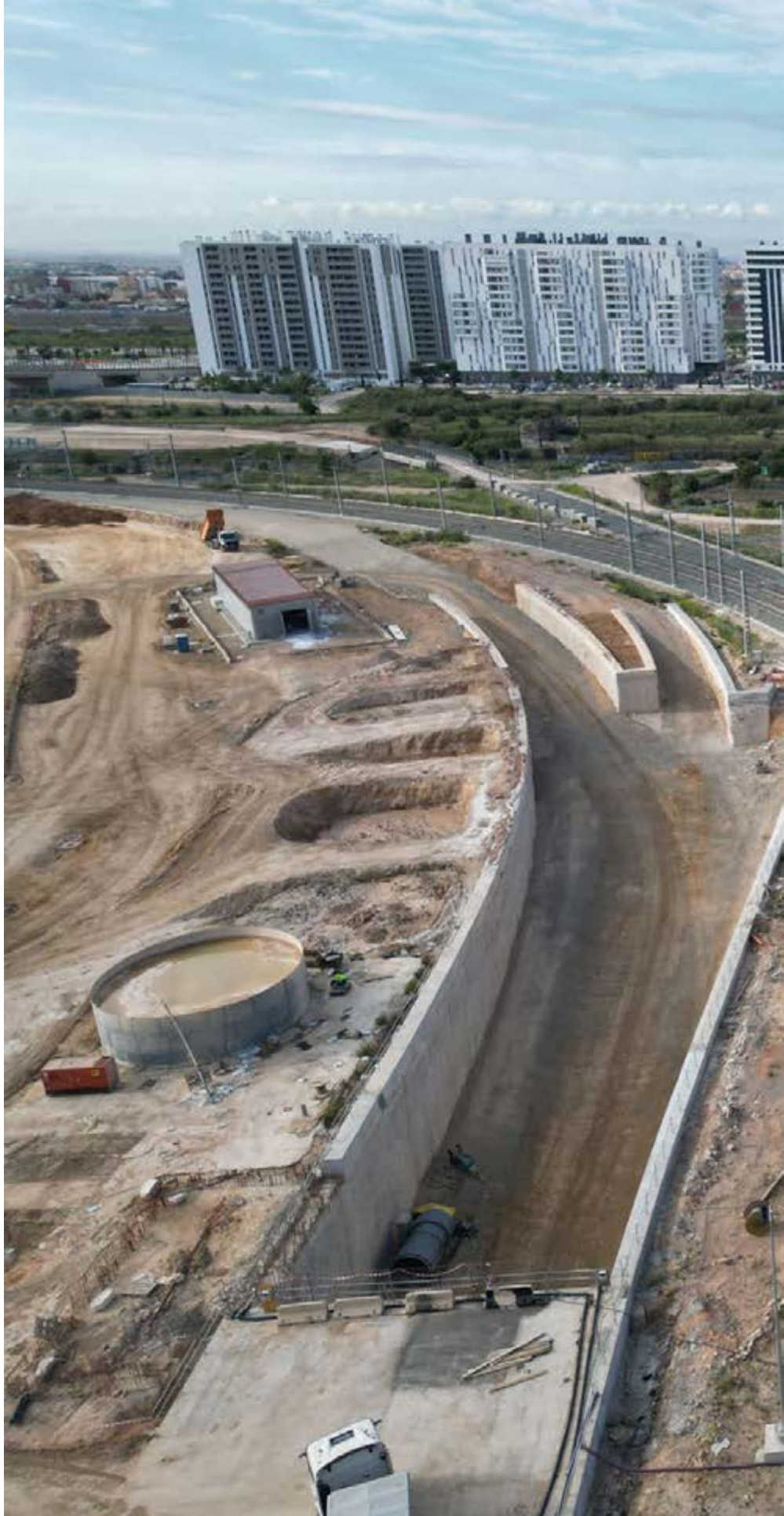
Desvíos provisionales y accesos a los túneles, en la zona sur.
