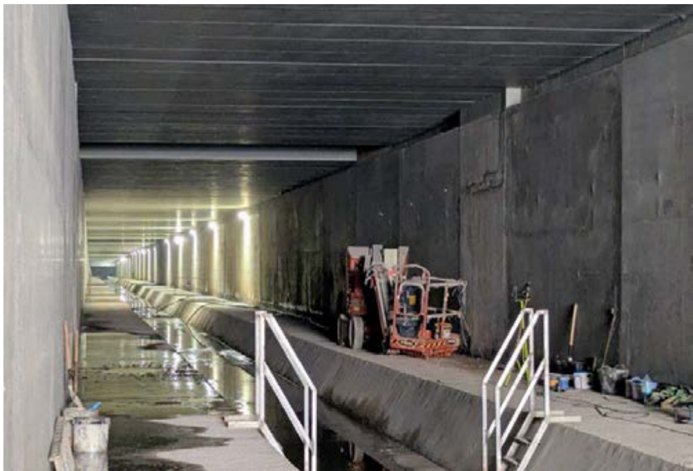
Tramo este del colector sur.
