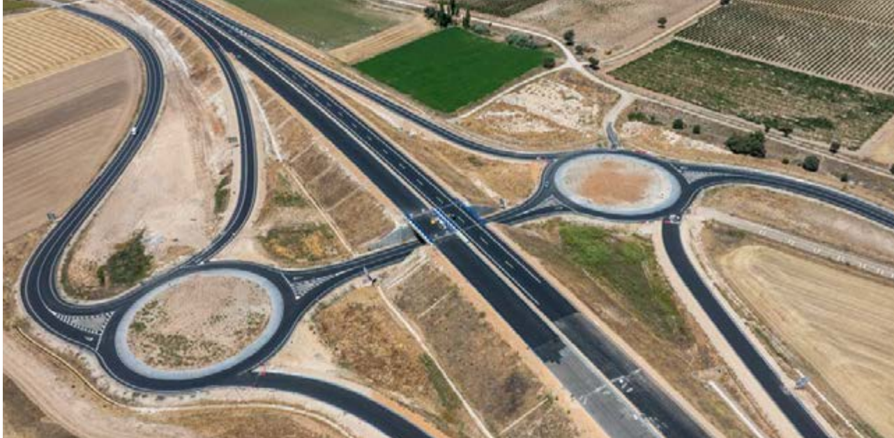
Enlace de San Bernardo, que conecta con la carretera VP-3001.
