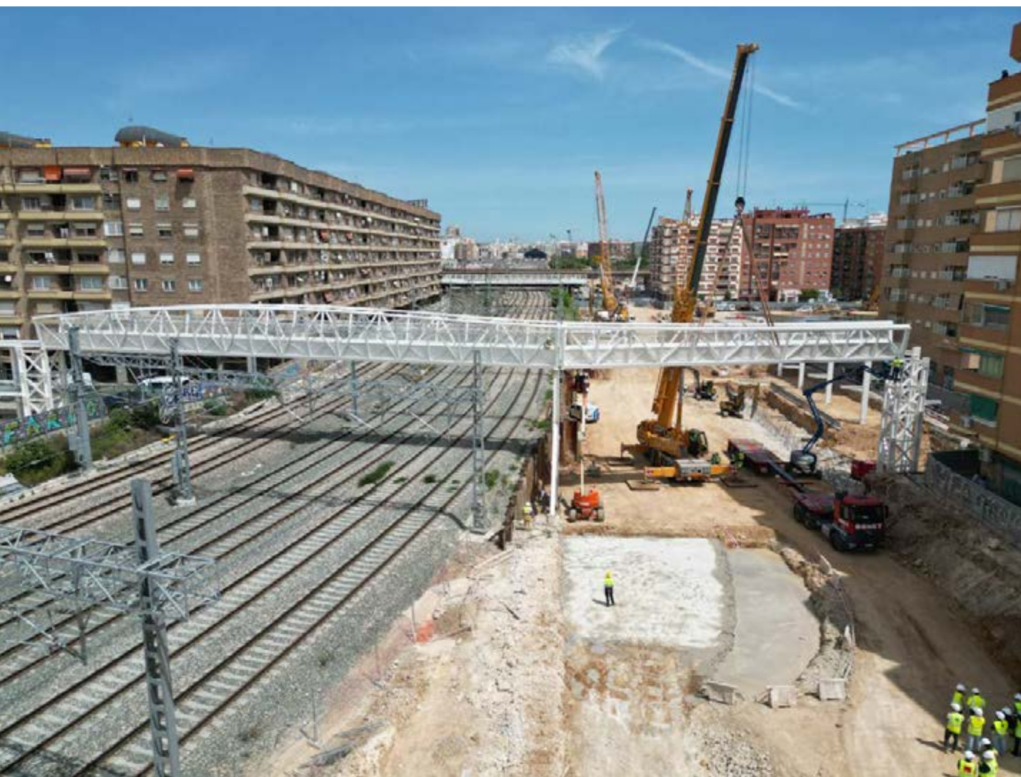
Nueva pasarela y ejecución de pilotes en la zona más estrecha del Canal de Acceso.
