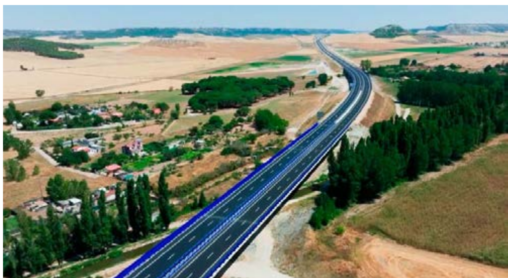
Viaductos sobre el Canal del Duero (en primer plano) y sobre el canal supletorio del Duero.
