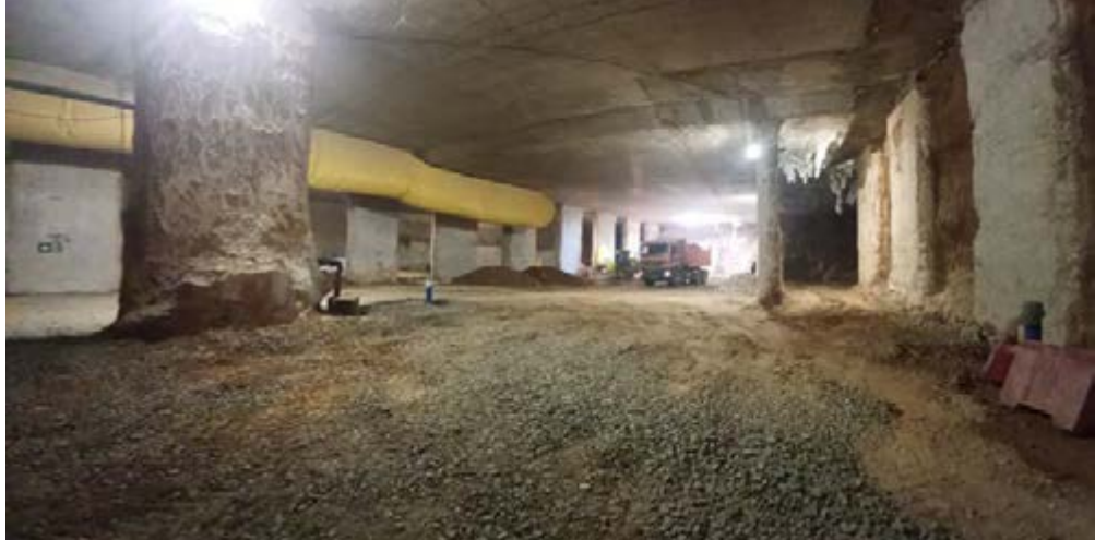
El túnel tiene una anchura aproximada de unos 50 metros.
