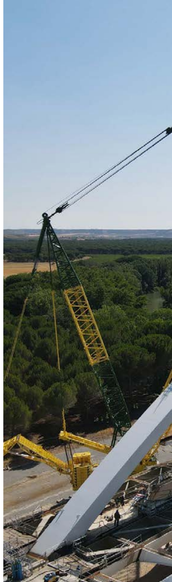
Montaje de arco del viaducto del Duero.
