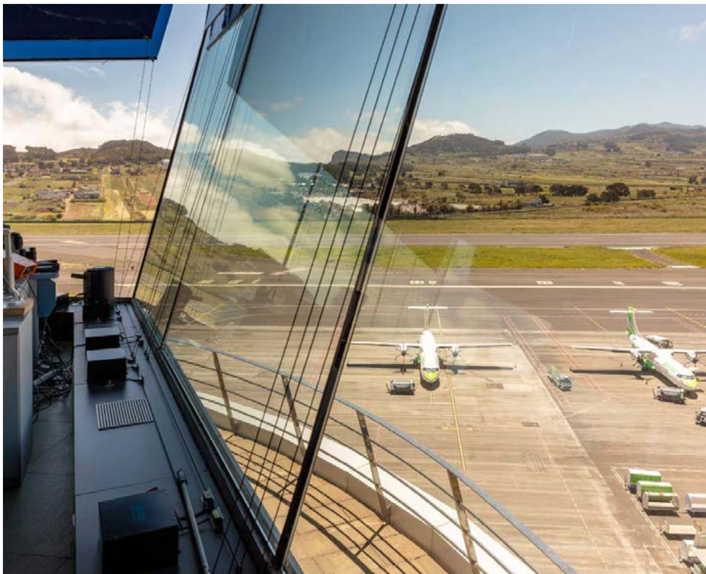
Torre de control del Aeropuerto Tenerife Norte-Ciudad de La Laguna.
