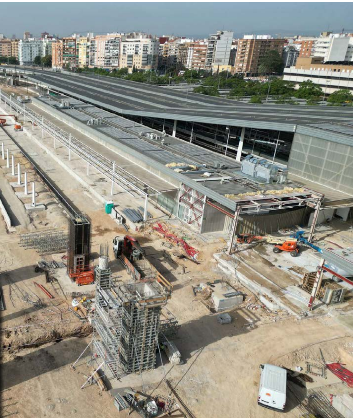
Ejecución de nuevos andenes de la estación Joaquín Sorolla.
