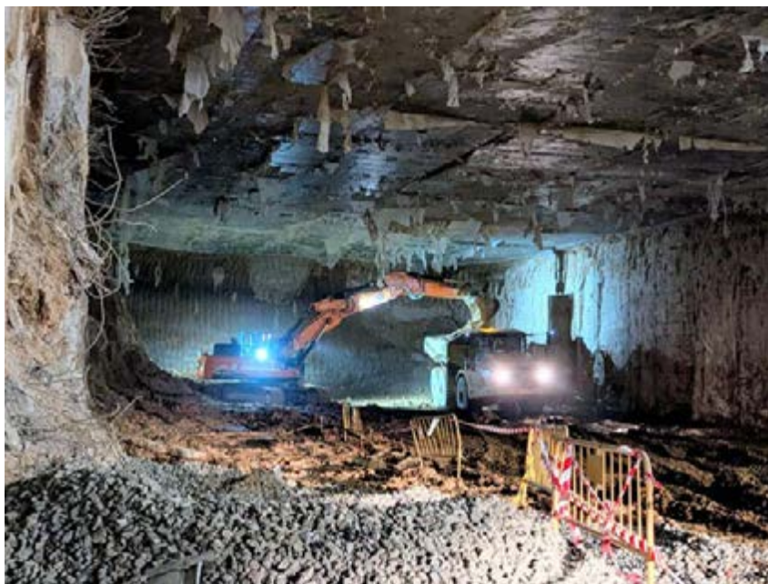
Excavación mediante medios mecánicos del frente central.
