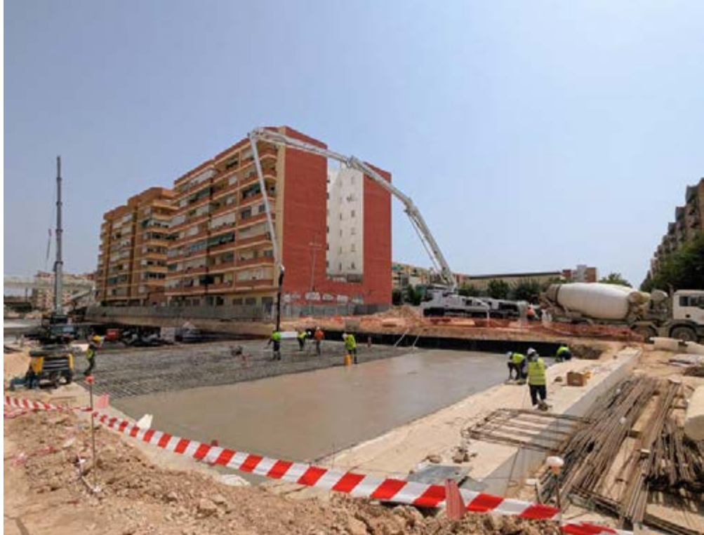
Hormigonado de la losa superior.
