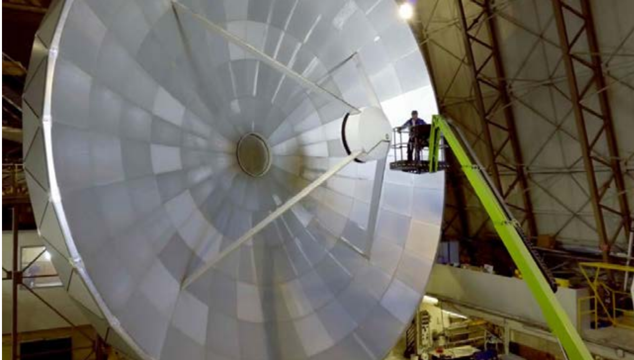
Labores de mantenimiento sobre una de las doce antenas de NOEMA. IRAM.
