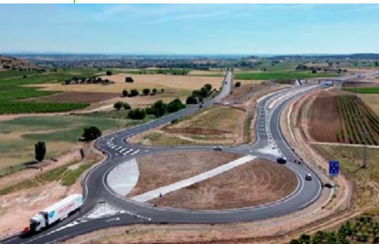
Glorieta de conexión entre la A-11 y la N-122.
