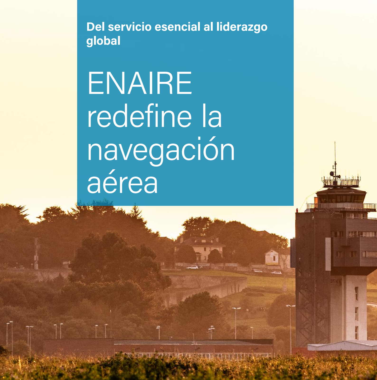
Torre de control del Aeropuerto Seve Ballesteros-Santander.
